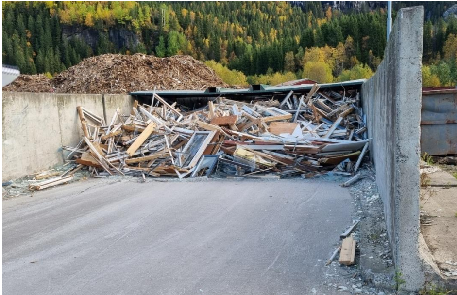
Figur 1: Knuste klorparafinholdige isolerglassruter, kun delvis lagret under tak.
