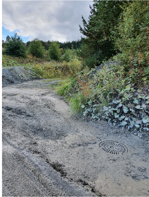
Bilde 2 Avrenning fra slambasseng til grunnvannsbrønn (Foto: Ida Frøya Svendsen v/Statsforvalteren i Trøndelag 20.09.2022)
