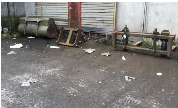
Bilde 5: Avfall på avveie inne på anlegget
