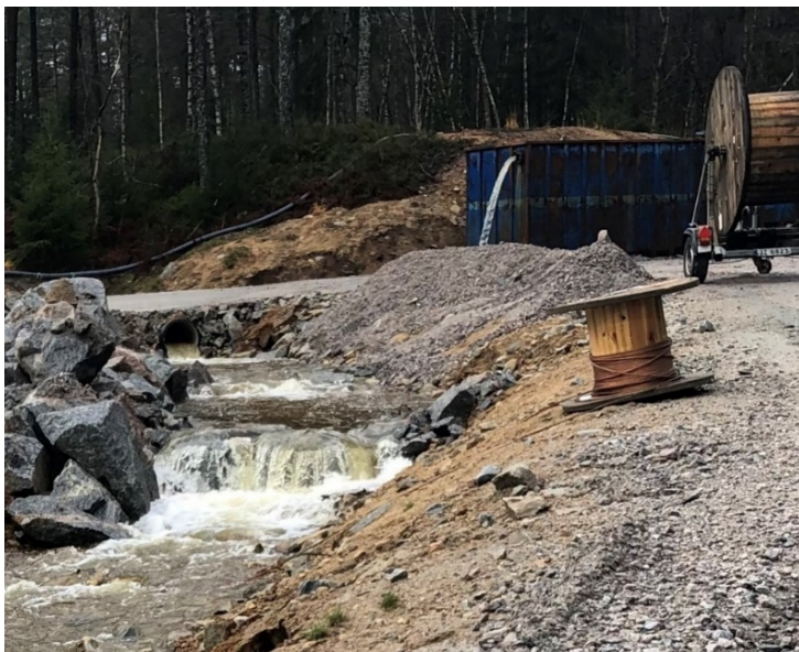
Bilde 3 – Viser renseanlegget på Flateland.
