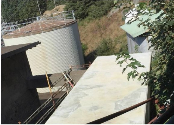
Bilde 1: Fundament for nye vasketårn for luktrensing.
