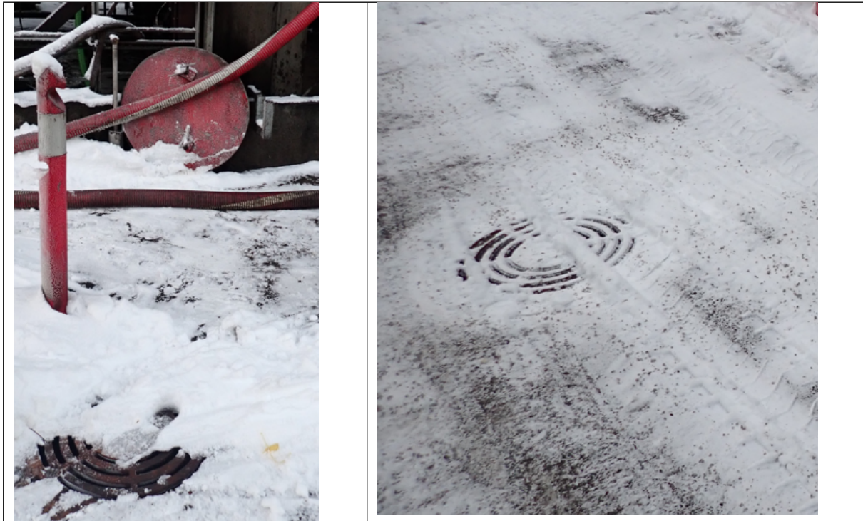
Overvannskummer som skulle vært blendet/stengt. Foto: Statsforvalteren i Oslo og Viken
