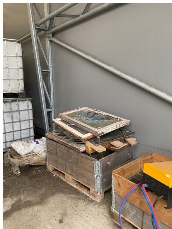
Bilde 10: PCB vinduer/klorparafinholdige isolerglassruter
