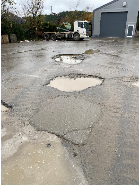
Bilde 5: Hull i utendørs dekket på nordsiden
