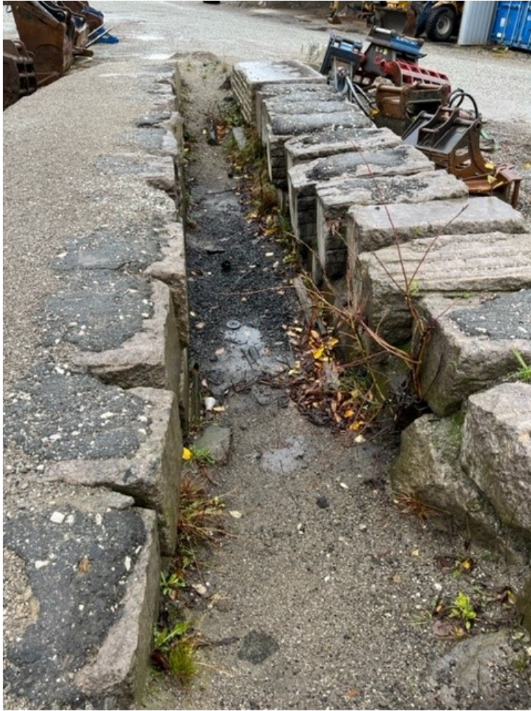
Bilde 1: Smøregrav med oljeforurensning
