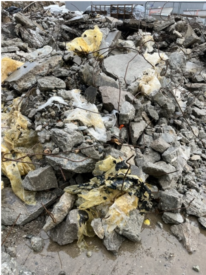
Bilde 4: plast i mellomlagret betong
