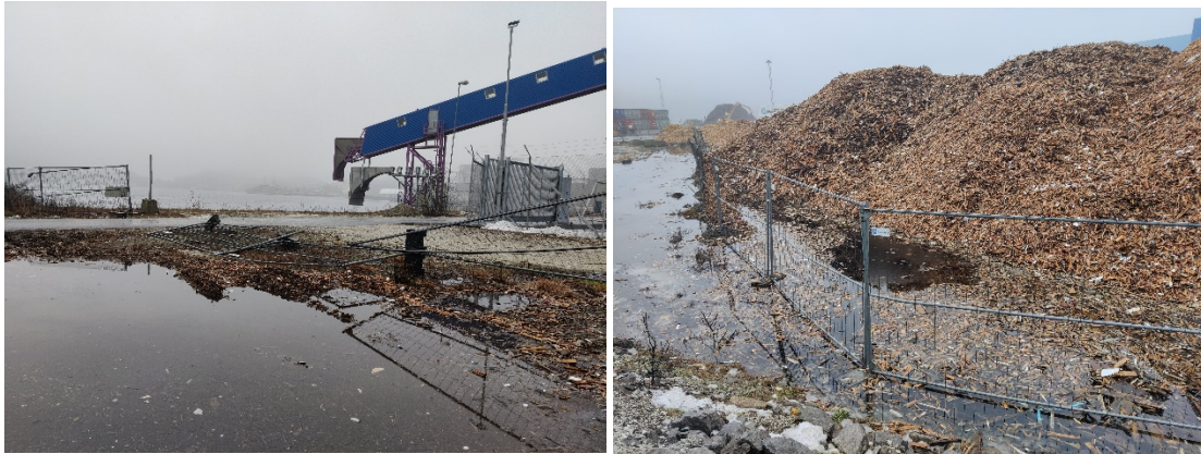
Bilde 1 og 2: Byggegjærder på sørvestsiden og nordøstsiden av lagerområdet.
