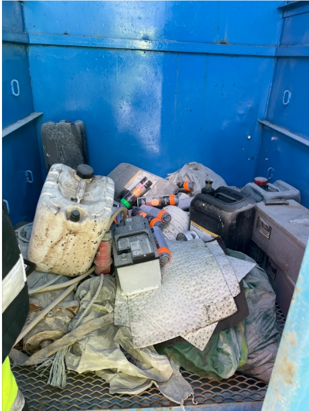
Bilde 1: Sammenblanding av farlig avfall og avfall i en mindre blå container
