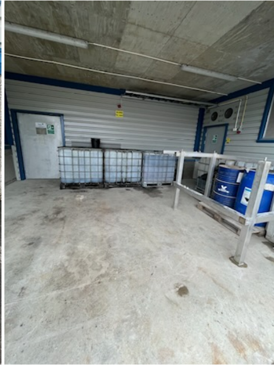
Bilde 2: Lagring av spillolje i IBC-kontainere uten merking
