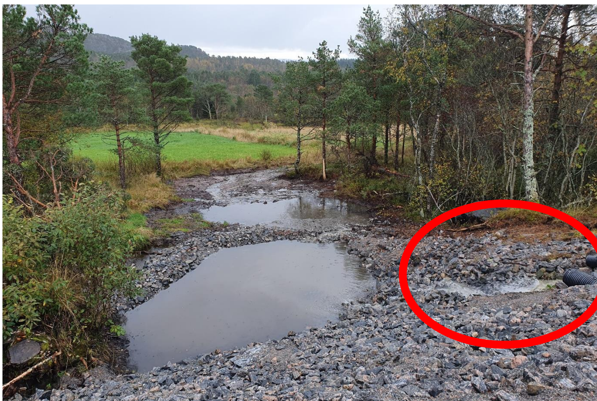
Bilde 1 Utslippspunkt fra oljeutskilleren etablert november 2020. Helt til høyre i bildet vises en betydelig mengde med vann fra oljeutskilleren. (Foto: Statsforvalteren i Trøndelag 3. oktober 2023)
