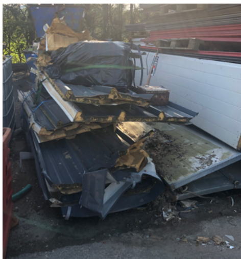
Bilde 4: Lagring av isolasjonsplater utendørs på grusdekke, uten skjerming for nedbør.
