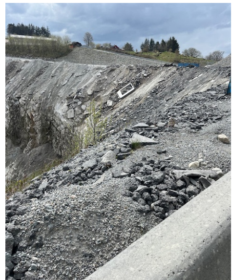
Bilde 2: Deponert asfalt og betongelementer
