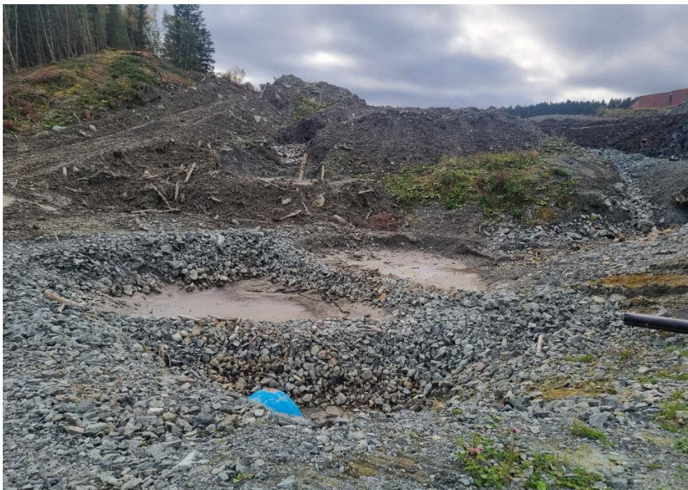
Bilde 1: Sedimentasjonsbasseng. Foto: Statsforvalteren i Trøndelag 20.09.2024
