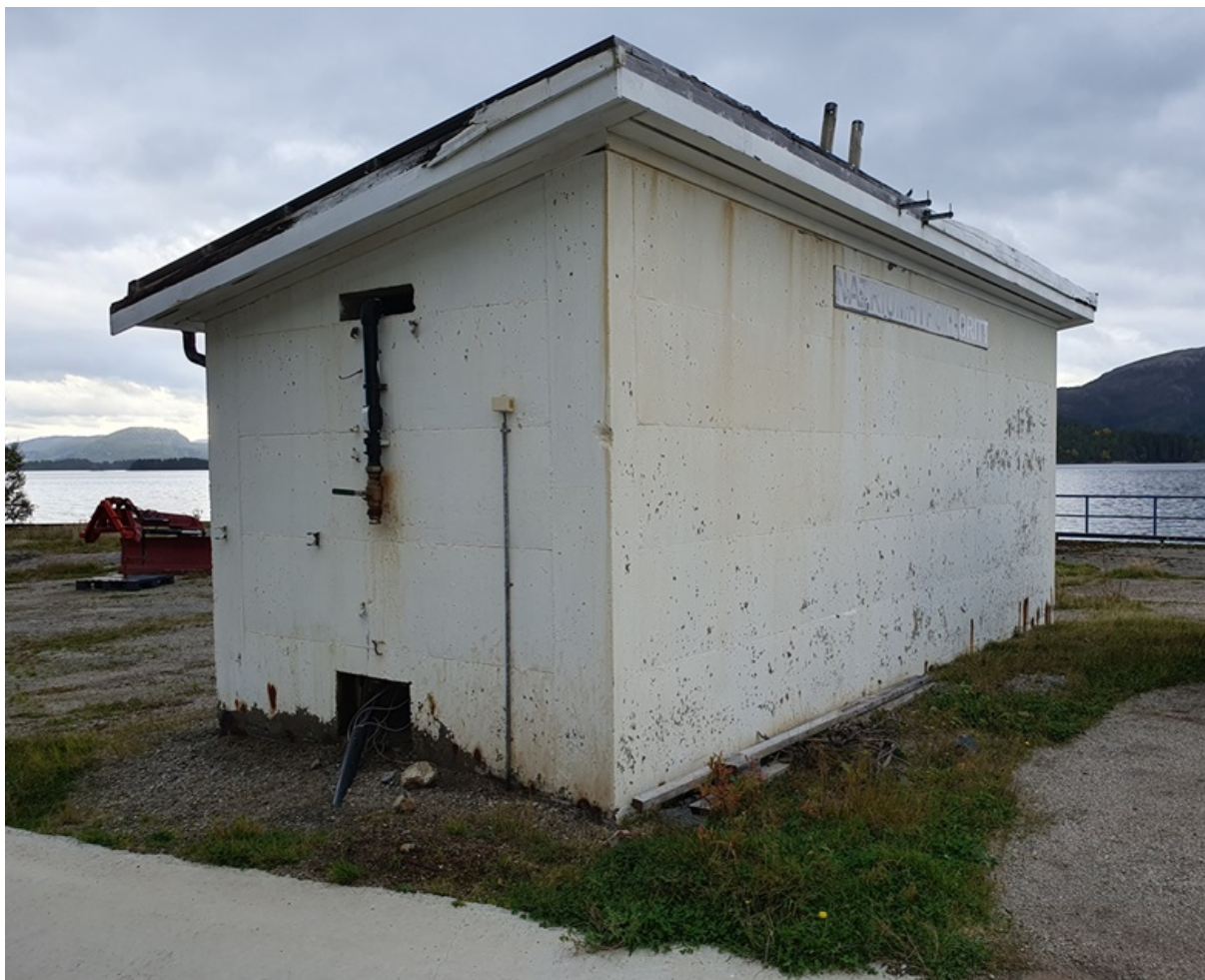
Figur 1 Hus som inneholder tank med natriumhypokloritt - VESO Vikan
