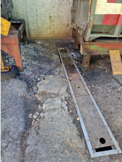
Bilde 1: Viser avløpsrennen på uteområdet. Foto: Statsforvalteren i Agder.
