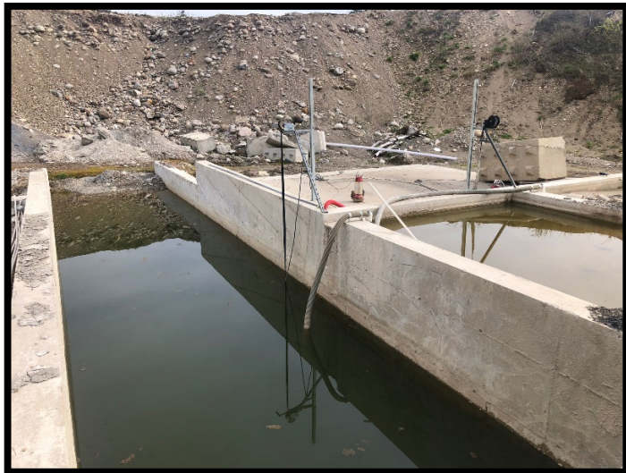
Bilder 7 og 8: Som viser betongslam og oppsamlingskar. Bilder fra Statsforvalteren i Østfold, Buskerud, Oslo og Akershus.
