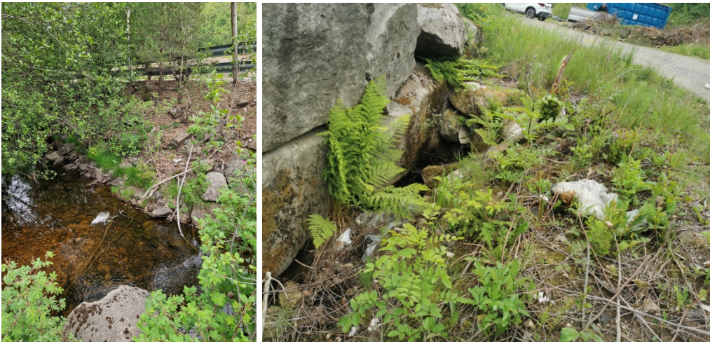
Bilde 2: Viser spredning av plastavfall til nærområdet. Foto: Statsforvalteren i Agder.
