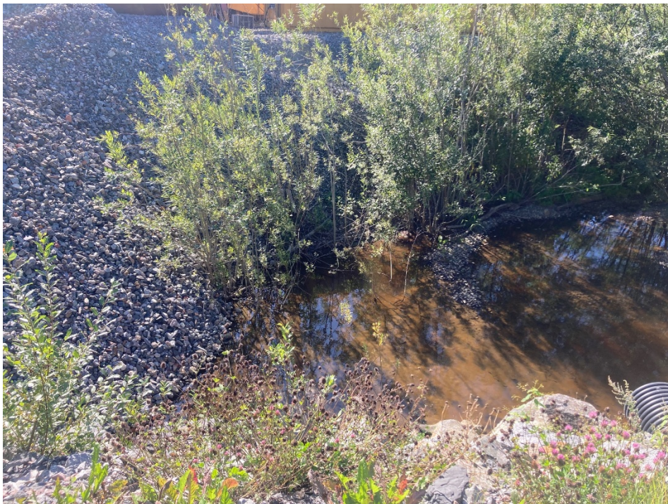
Masser som delvis er fylt ut i bekk og manglende kantvegetasjon (Foto: Statsforvalteren i Østfold, Buskerud, Oslo og Akershus)
