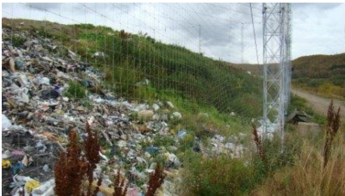
Bildet viser deler av deponikanten hvor det er fylt ut for mye avfall utover bunntetningen – deler av avsluttet og beplantet område i bakgrunnen)
