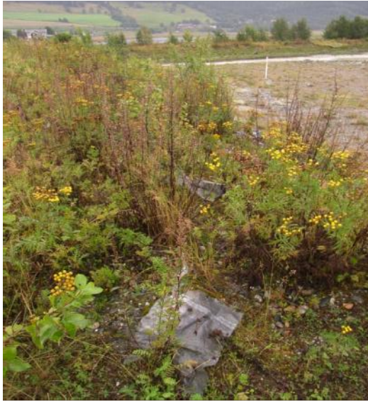
7 Deponi nedre slutt Membran synlig mot kanal (sett mot elv og fjord)
