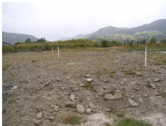
4 Grunnvannsstasjoner nedre del deponi sett mot ovnshall. Avslutningsvoll for siste deponietappe synlig i bakgrunn.
