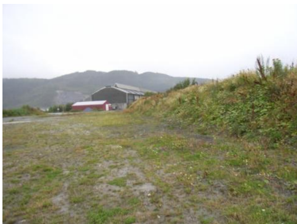
3 Deponiterrasering sett mot ovnshall
