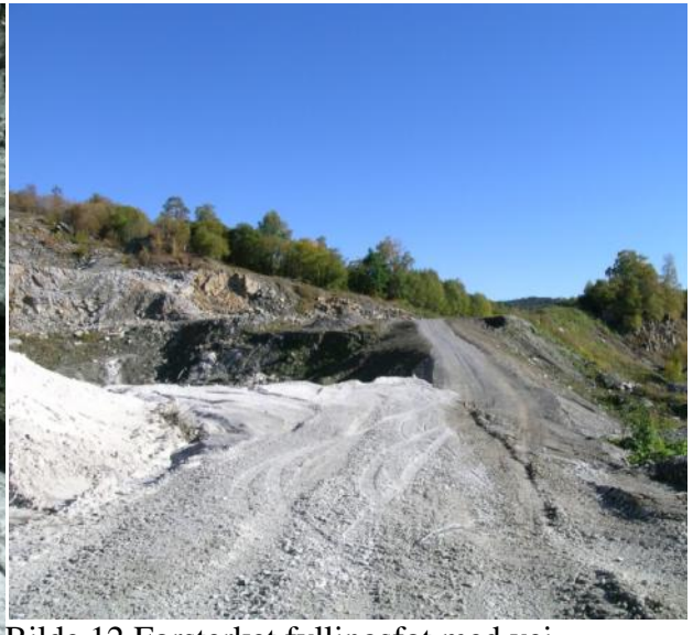
Bilde 12 Forsterket fyllingsfot med vei
