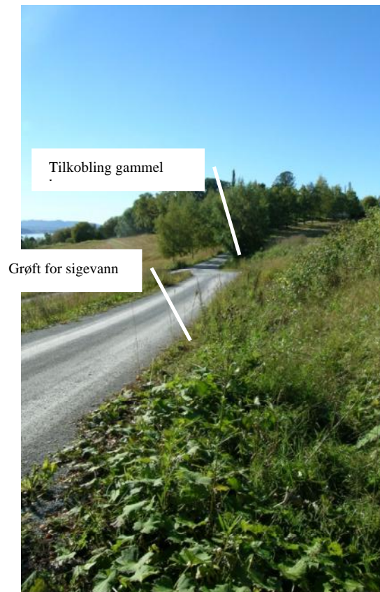
Bilde 23 Trase for utløp sigevann sett "nedover" fra deponi
