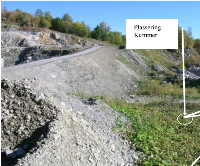
Bilde 13 Forsterket fyllingsfot med vei
