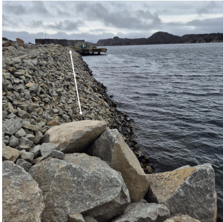
Figur 1: Plastringstiltaket. Den gjenstående strekningen som skal plastres er vist med hvit pil.
