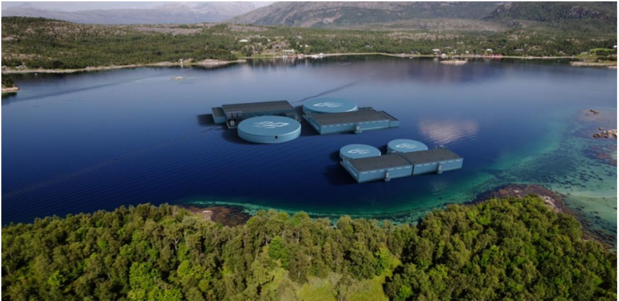
Figur 1: Eksempel på et Multigen anlegg bestående av en rekrutteringsplattform (med to tanker) og to matfiskplattformer. Bilde hentet fra vedlegg 15 (skisseprosjekt) i søknaden.
